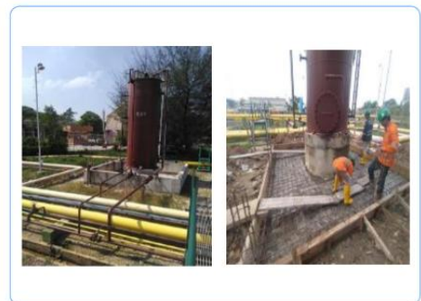
Gambar 9. Dokumentasi pembuatan jumper line
