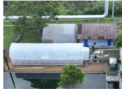
Fasilitas Pembibitan Geo-Farm
