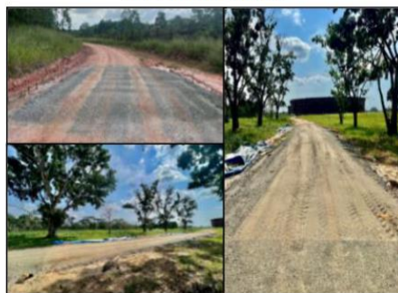
Gambar 17. Lokasi Jalan Setelah Program RAVING WBM di Terminal Santan
