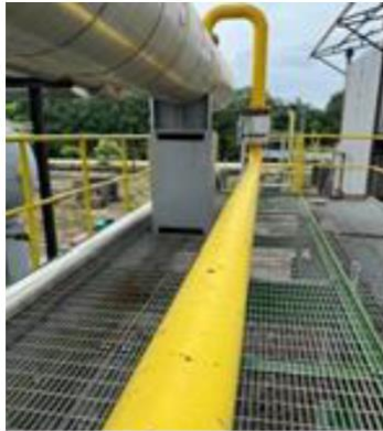
Gambar 1. Sebelum Implementasi Pilitem
