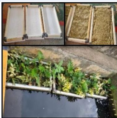
Gambar 23. Pembuatan Modul Meraki dan Impelementasi Modul pada Bak Sedimentasi IPAL
