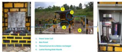
Gambar Aplikasi Rekondisi Baterai Aki ke Solar Panel Unit Lime Mixing
